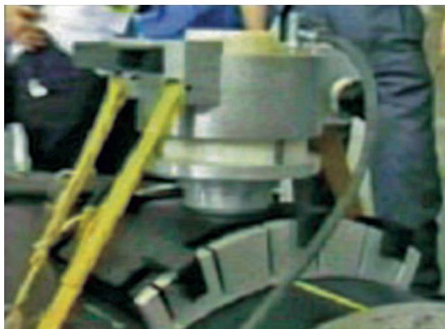
Рис. 9. Монтаж ремонтной накладки способом Top-Loading с использованием прижимного устройства FRIATOP.
