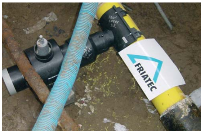
Рис. 1. Монтаж отвода от существующего газопровода.
